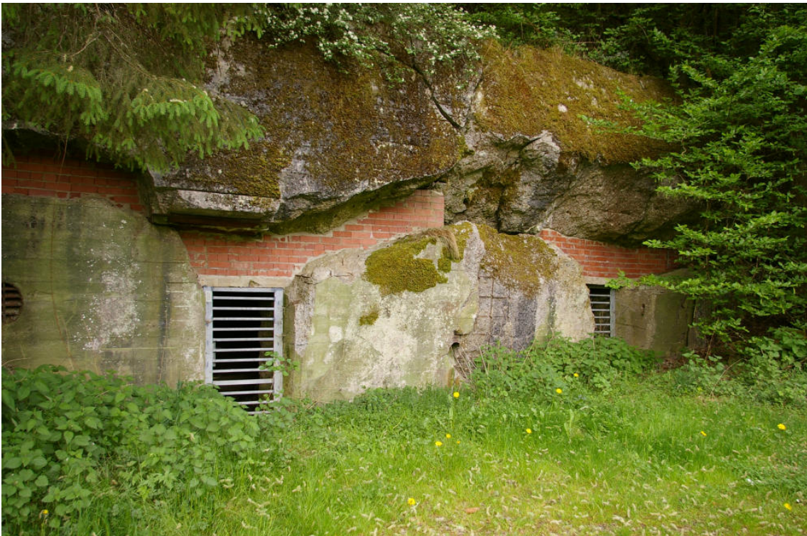
Abb. 24: Bunker bei Bollendorf, als Fledermausquartier gesichert
