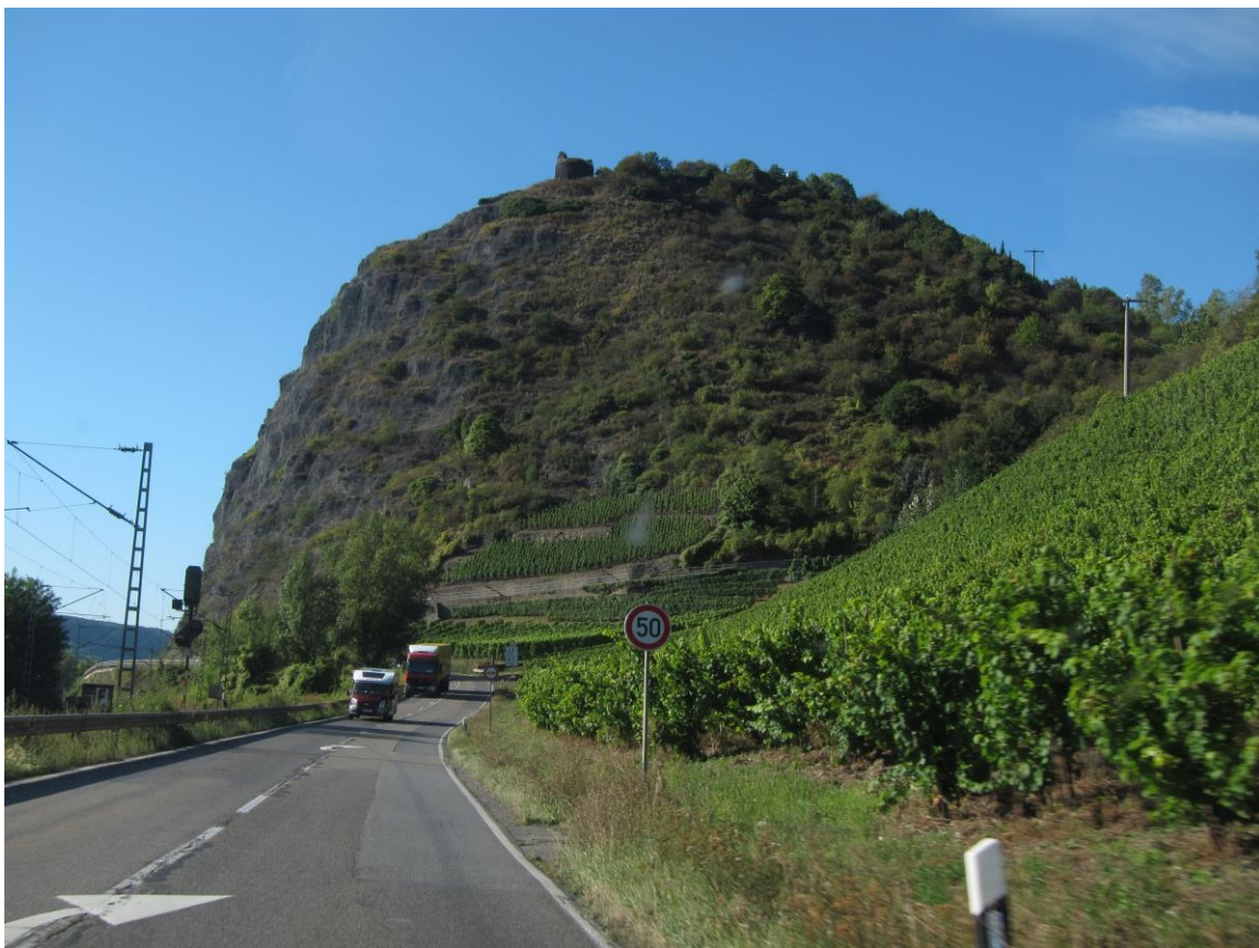
Abb. 2: Die Felsen unterhalb der Ruine Hammerstein sind mit Felsenbirnengebüsch und Felspioniergras bewachsen. An der Straße sind umfangreiche Steinschlag-Sicherungen angebracht. 27.09.2012
