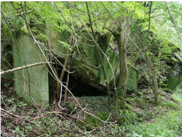
Abb. 39: Alter Westwall-Bunker im Olker Bachtal: Potentielles Fledermaushabitat. Foto: Annette Schäfer Koordinaten: 322441 / 5520684 Aufnahmedatum: 30.07.2012
