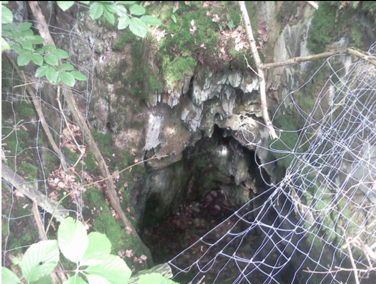
Abb. 05: Schieferstollen mit Drahtsicherung nördlich der „Kanzel“
