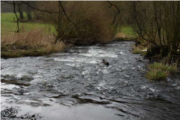
Abb. 46: Rückbau eines Mühlenwehres in der Ruwer südlich Hentern in eine Sohl- rampe zur Wiederherstellung der Durchgängigkeit für Wassertiere im Rahmen des Naturschutzgroßprojekts des Bundes „Ruwer und Neben- bäche“. Foto: Hildegard Wey Koordinaten: 333670 / 5497945 Aufnahmedatum: 17.03.2014
