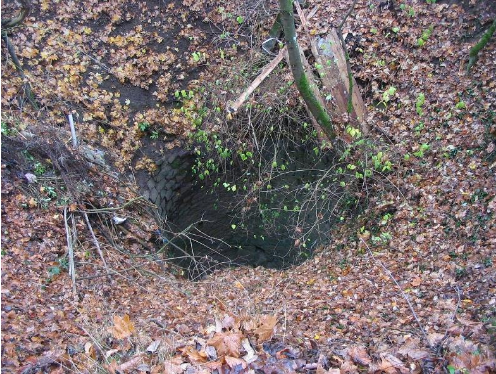
Abb. 11: Offener Schacht des Stollenabschnitts „Teddy“ in Niedermendig. Die Schächte sind mehr als 25 m tief und oftmals nur durch einen Zaun gesichert.
